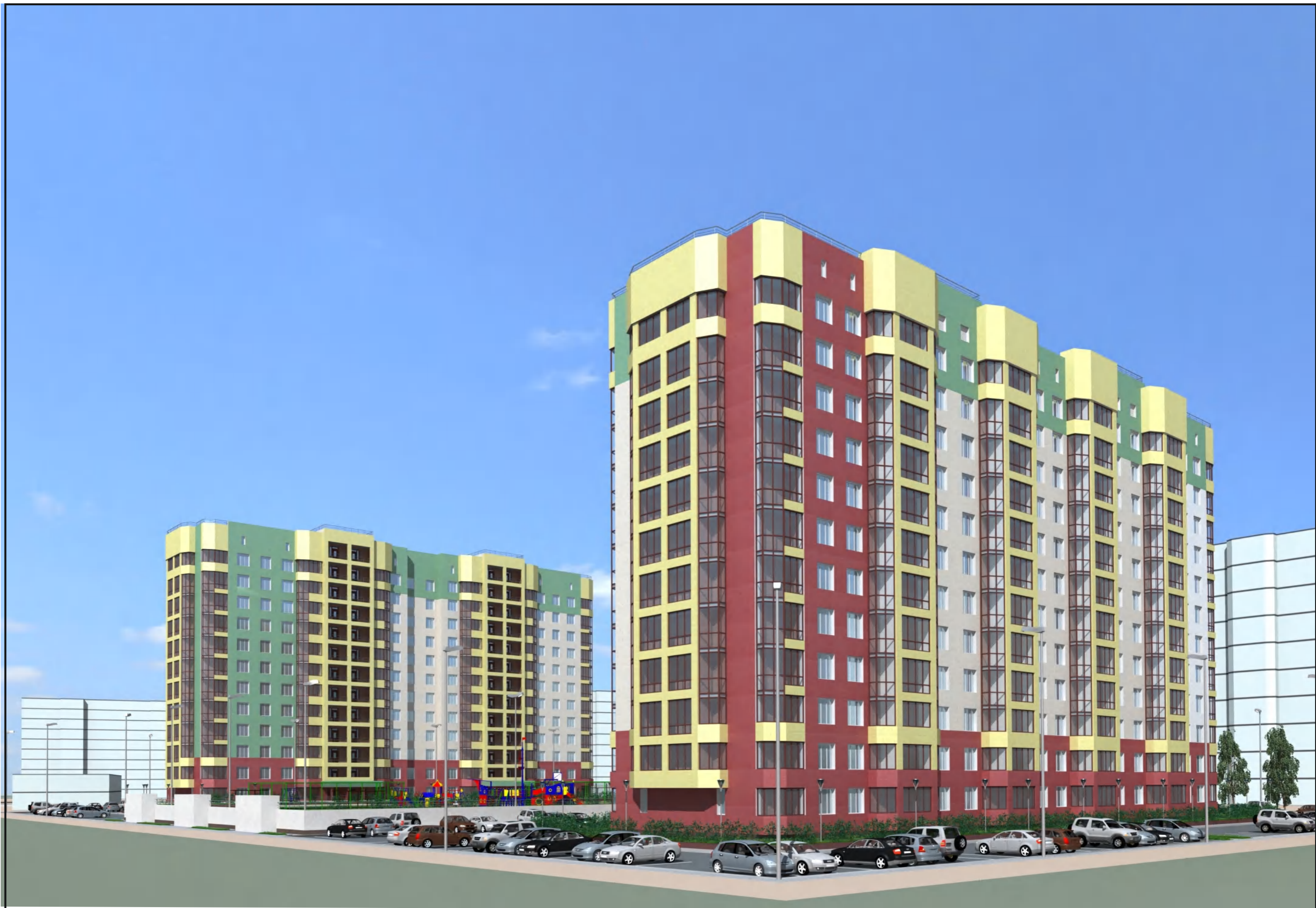
ДВА МНОГОКВАРТИРНЫХ ЖИЛЫХ ДОМА С ПОДЗЕМНОЙ ПАРКОВКОЙ ПО УЛ. ГЕОРГИЯ ВЕЛИЧКО № 11 В Г. ХАНТЫ-МАНСИЙСКЕ
